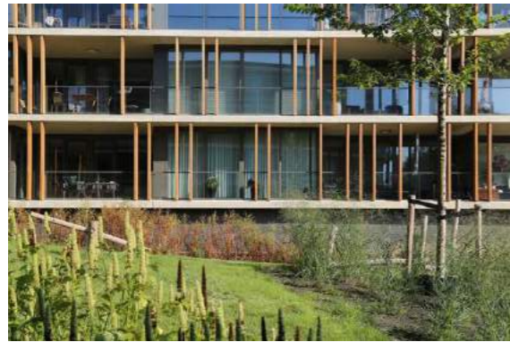
het maaiveld spoelt tegen het gebouw
